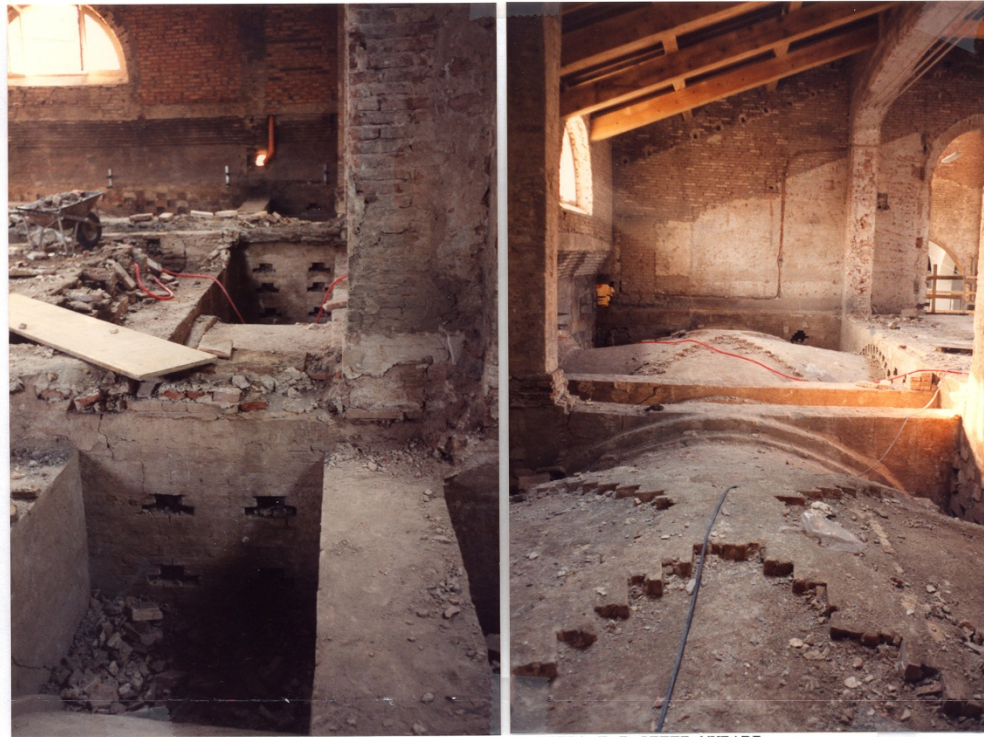
L'ESTRADOSSO DELLE VOLTE A CROCIERA E I SETTI MURARI DI COLLEGAMENTO TRA I PILASTRI BINATI
