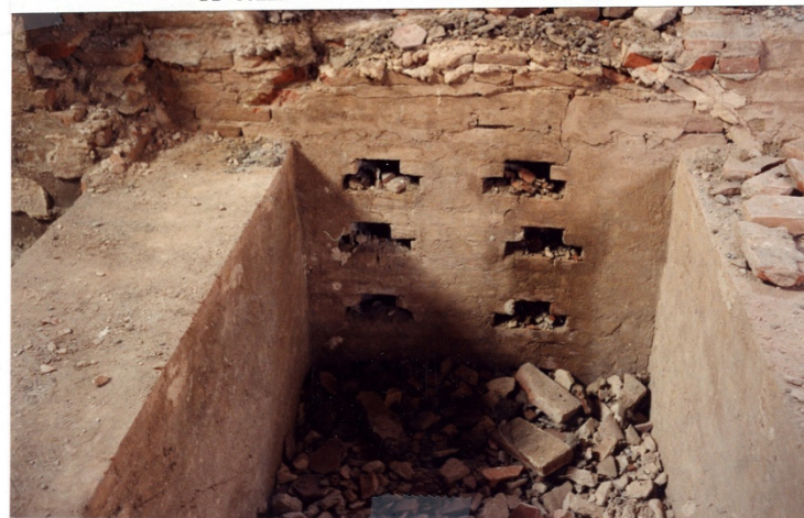
L'ESTRADOSSO DELLE VOLTE A CROCIERA E I SETTI MURARI DI COLLEGAMENTO TRA I PILASTRI BINATI
